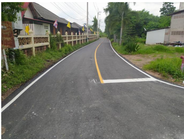
13.โครงการปรับปรุงผิวจราจรด้วยแอสฟัลต์ติกคอนกรีต หมู่ที่ 9 ซอยทุ่งขวาง 5
