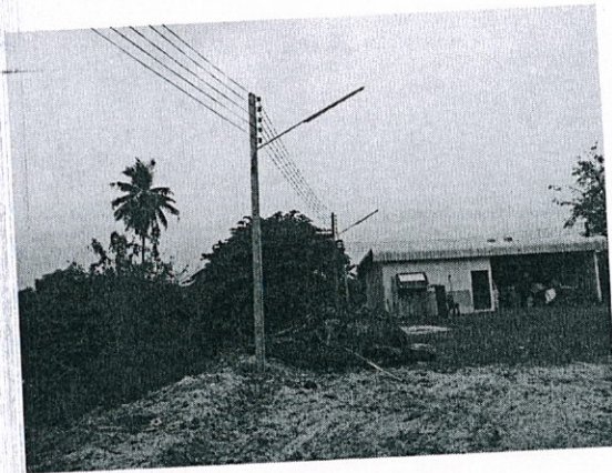
๑๖. โครงการปักเสาพาดสายไฟพร้อมติดตั้งโคมไฟส่องสว่าง บริเวณด้านหลังอาคารสำนักงาน อบต.ทุ่งขวาง
