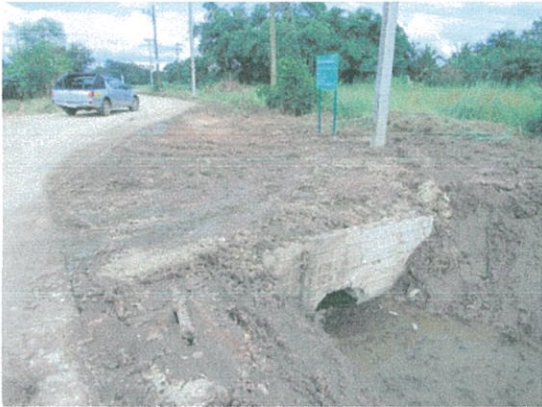
๒๔. โครงการวางท่อระบายน้ำข้างทาง หมู่ที่ ๙ บริเวณหน้าบ้านนายบุตร แก้วทอง
